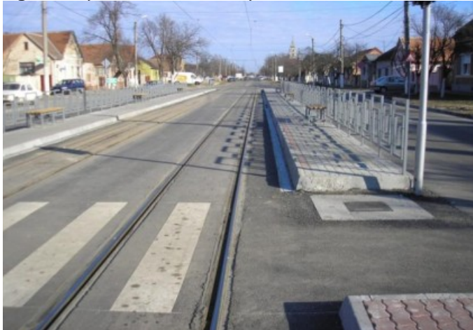
Fig.14 - Stație tramvai, str. Renașterii
