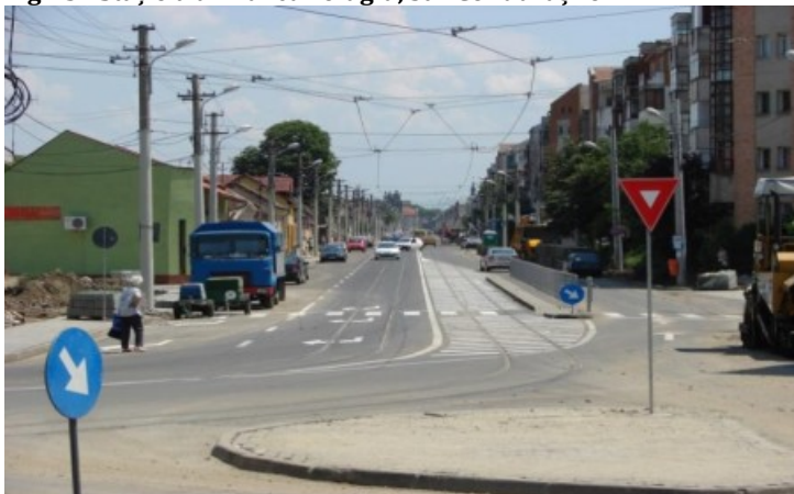
Fig.15 - Stație tramvai cu refugiu, str. Condurașilor
